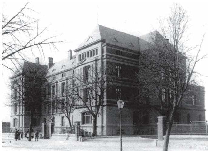
Abb. 3: Die Augenklinik unmittelbar nach ihrer Eröffnung. Die 1899 eingeweihte Klinik für Ohren- und Kehlkopfkrankheiten ist hier noch nicht zu erkennen. Foto: Universitätsarchiv Rostock
